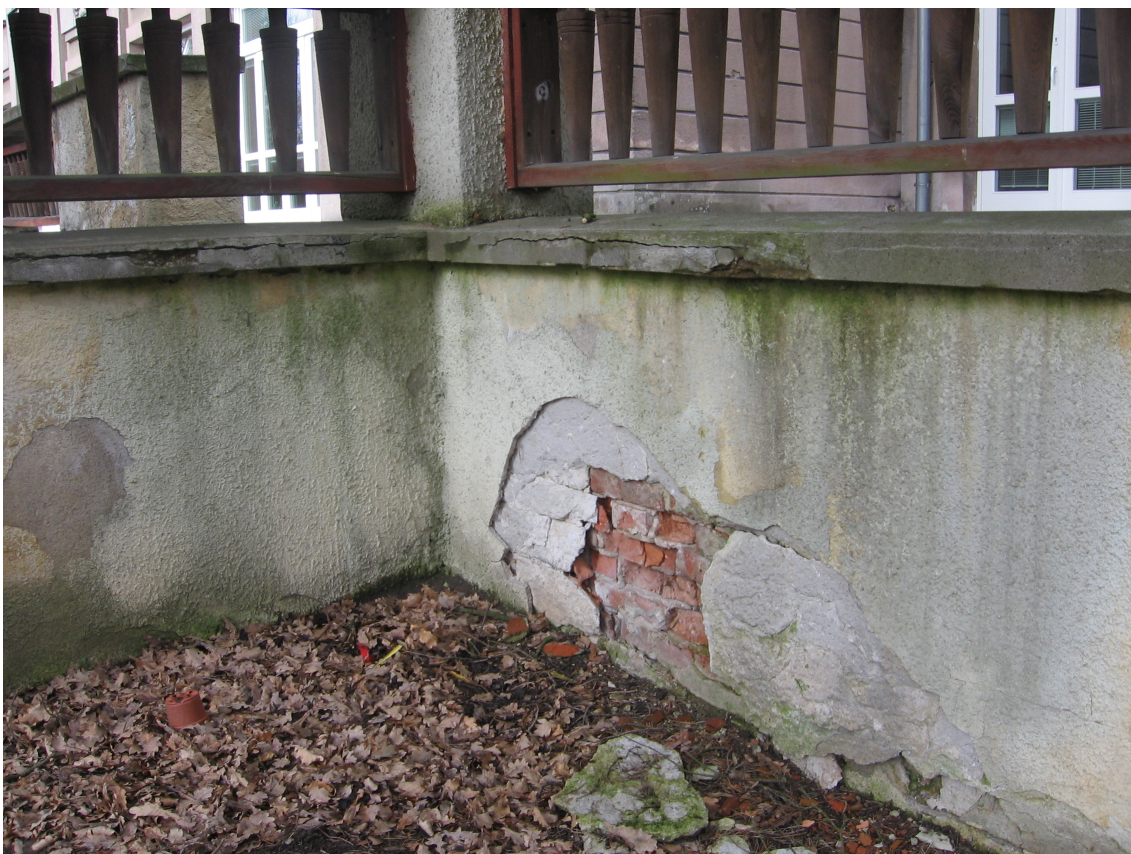
degradace cihel opěrné stěny
