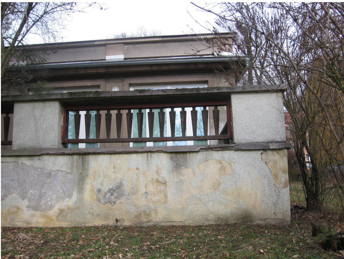
trhlina u rohu zdí, degradace betonových obrub a omítky
